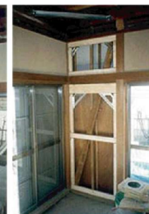
▲次に、下地を入れます。下地も強固な金物で補強してあります。
