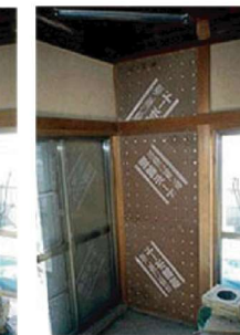
▲最後に、強度の強い耐震ボードを取り付けます。この後、内装仕上げをして完成です。
