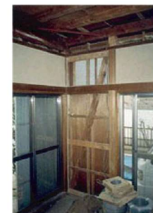
▲内装材を撤去します。
