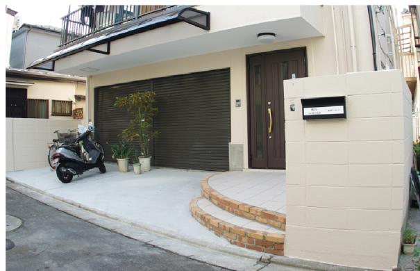
▲入出庫のしやすさを考慮し、既存コンクリートブロック塀を切り取りました。シャッター前にアルミ製の庇を設置しました。
