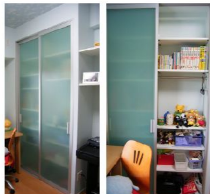
半透明の樹脂製パネル扉の内部には可動棚とハンガーパイプを取付け
