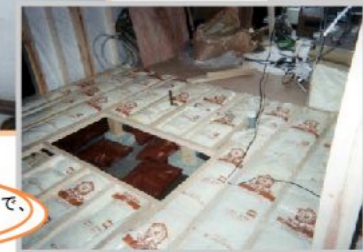
■ 断熱材+木炭 施工中
