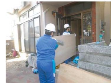
▲養生材の搬入作業を体験中。
