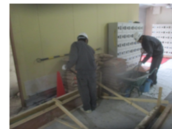
▲コンクリートの流し込み作業を体験中。
