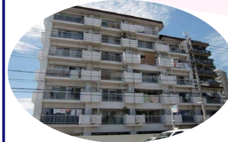
Hマンション様 耐震改修工事
