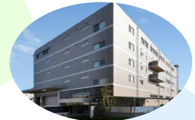
N社様 新築工事
